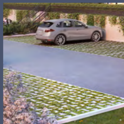
Stationnements extérieurs intégrés en Evergreen
